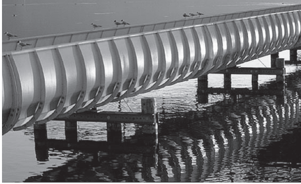
Bild 1.7: Brückenkonstruktion aus GFK [14]
